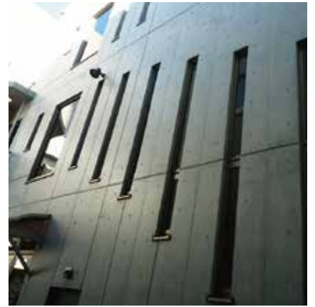
写真1 コンクリート打放しの建築物
