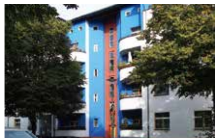
図4 シェーンランカー通りの集合住宅(1926-27)
